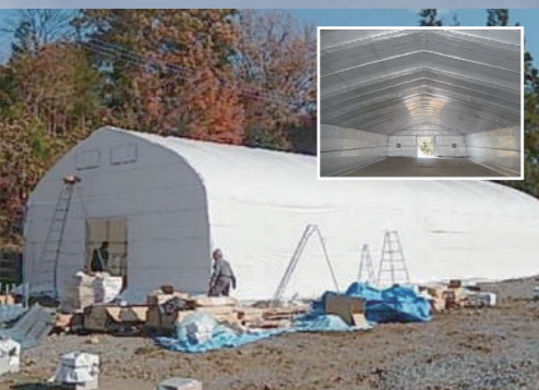
ビニールハウスの内側に施工
