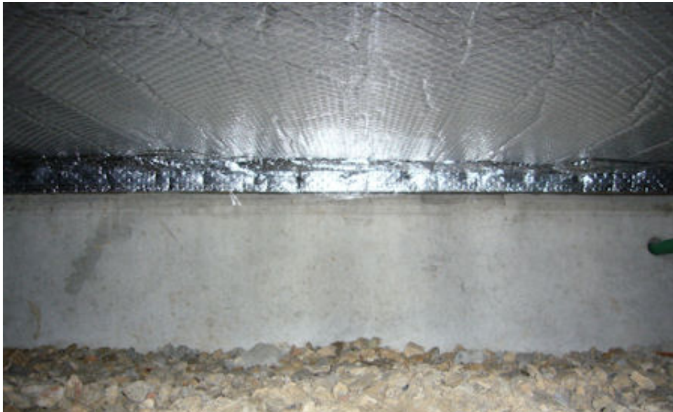
タルキ下に貼り付けています
